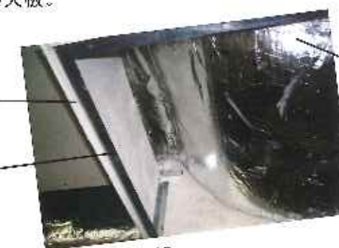
防火板連支架
