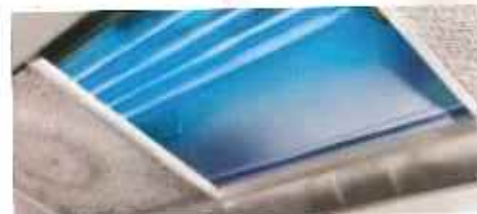
(上) 安裝在抽煙管道內的超紫外線催化器。
